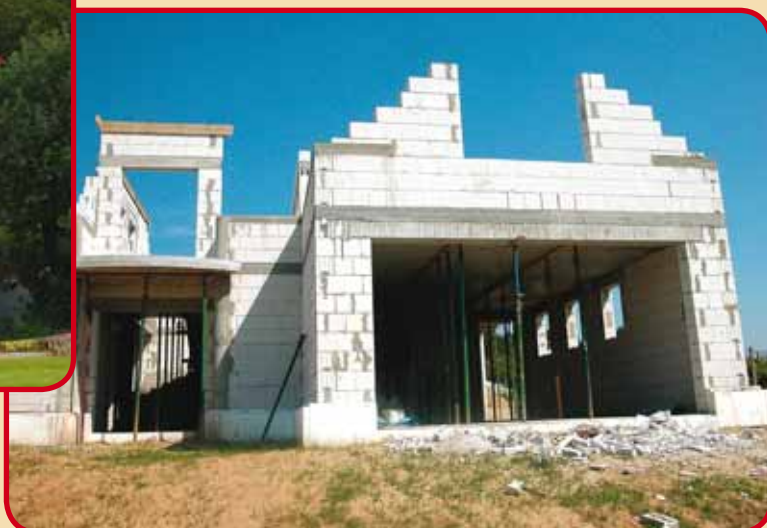
FÁZE VÝSTAVBY KMB SENDWIX - BZENEC
