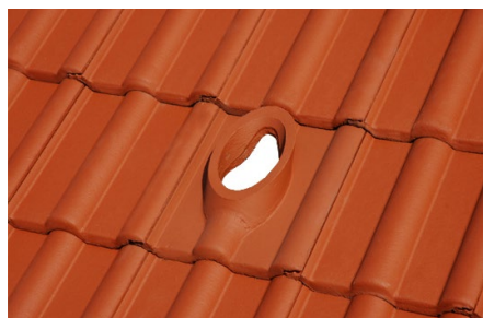
Detailní záběr na tašku prostupovou ve střeše
