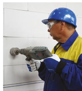
Vrtání otvoru pro elektroinstalační krabice
