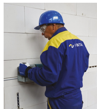
Řezání vodorovné instalační drážky
