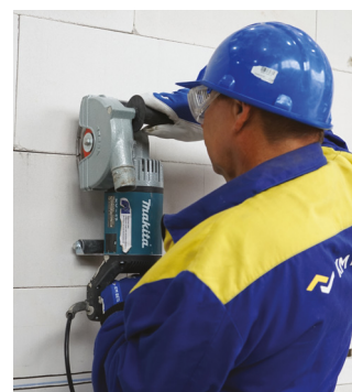
Řezání svislé instalační drážky
