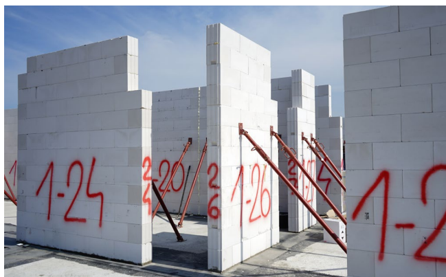
Příklady ukotvených a srovnaných stěn dle kladečského plánu
