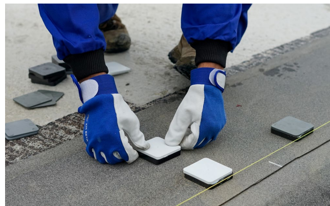
Montážní podložky jsou součástí dodávky cihlových stěn.
