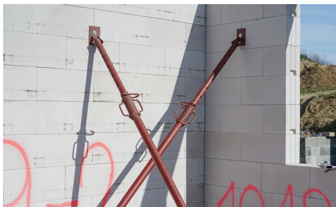
Příklady ukotvených a srovnaných stěn dle kladečského plánu
