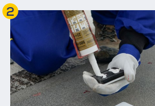
Osazení distančních podložek
