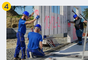
Osazení cihlové stěny
