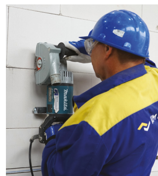
Řezání svislé instalační drážky
