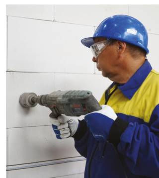
Vrtání otvoru pro elektroinstalační krabice
