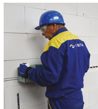
Řezání vodorovné instalační drážky
