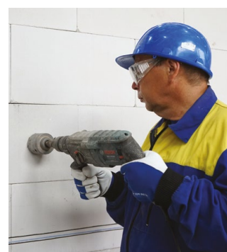
Vrtání otvoru pro elektroinstalační krabice
