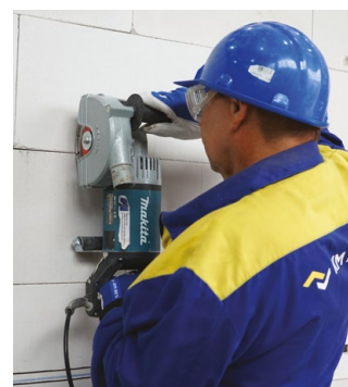
Řezání svislé instalační drážky
