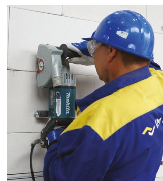
Řezání svislé instalační drážky
