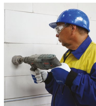
Vrtání otvoru pro elektroinstalační krabice
