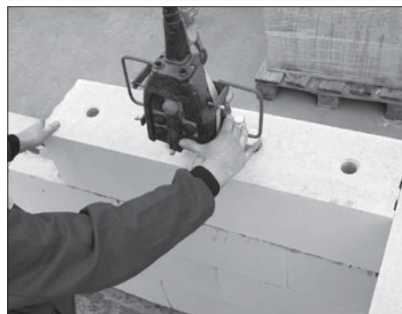
Manipulace s břemenovými kleštěmi H21
