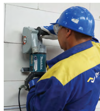
Řezání svislé instalační drážky
