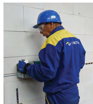
Řezání vodorovné instalační drážky
