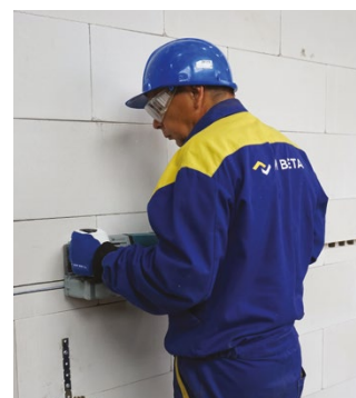
Řezání vodorovné instalační drážky
