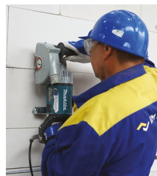
Řezání svislé instalační drážky
