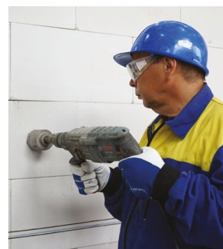
Vrtání otvoru pro elektroinstalační krabice
