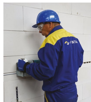
Řezání vodorovné instalační drážky
