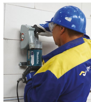
Řezání svislé instalační drážky
