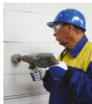
Vrtání otvoru pro elektroinstalační krabice
