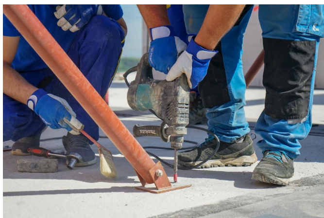
Ukotvení šikmé vzpěry do základové (stropní) desky
