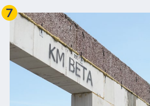
Ztužení konstrukce stropem nebo věncem
