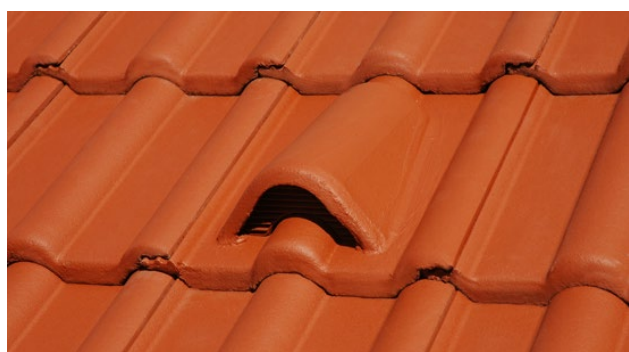
Detailní záběr na tašku větrací ve střeše
